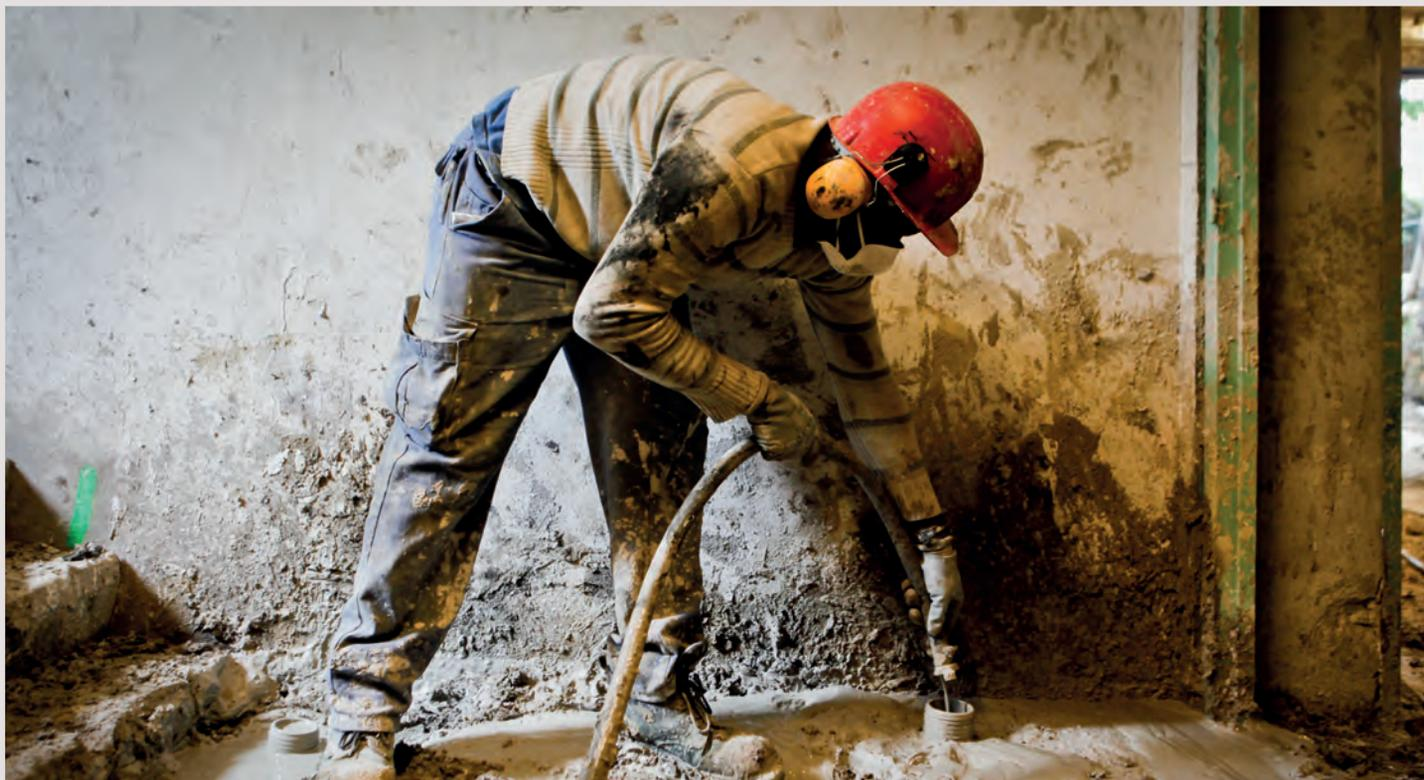
Depuis le début du mois de juillet, un chantier délicat et technique est en cours autour et sous le bâtiment La Source, Parc de Freising. En vue du renforcement des fondations, une reprise en sous-œuvre a déjà nécessité l'injection de 20 tonnes de béton dans 67 micro-pieux qui serviront également à solidifier l'édifice par 10m de fond.
